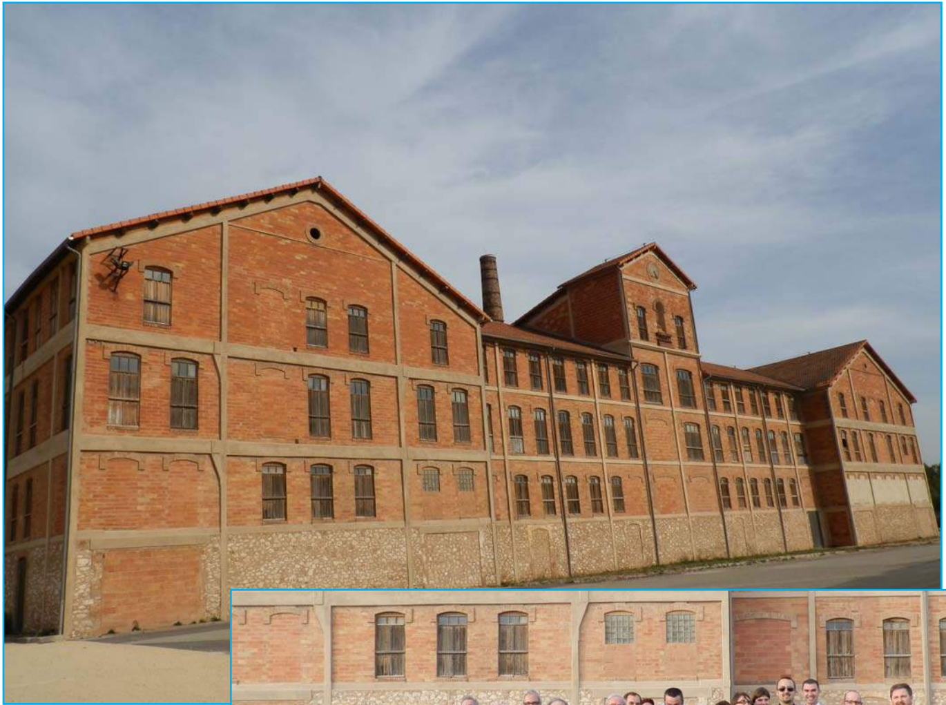
1/ La façade du Site-Mémorial
